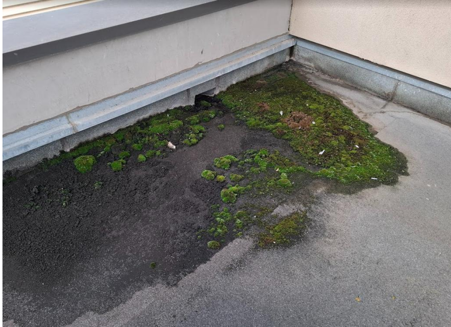
Terrasse du plancher R+1 du bâtiment 1. De la mousse au niveau de l'exutoire EP. A nettoyer.
