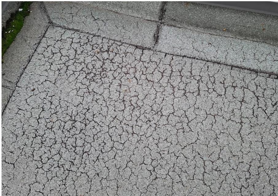
Terrasse du plancher R+1 du bâtiment 1. Certaines zones sont très faïencées mais M. LAGARDE nous indique ne pas avoir eu de désordres dans les pièces en-dessous.
